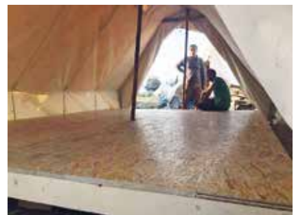
Dank der Volkshilfe-SpenderInnen können u. a. Holzböden zum Schutz vor Schlamm und Nässe in die Zelte verlegt werden
